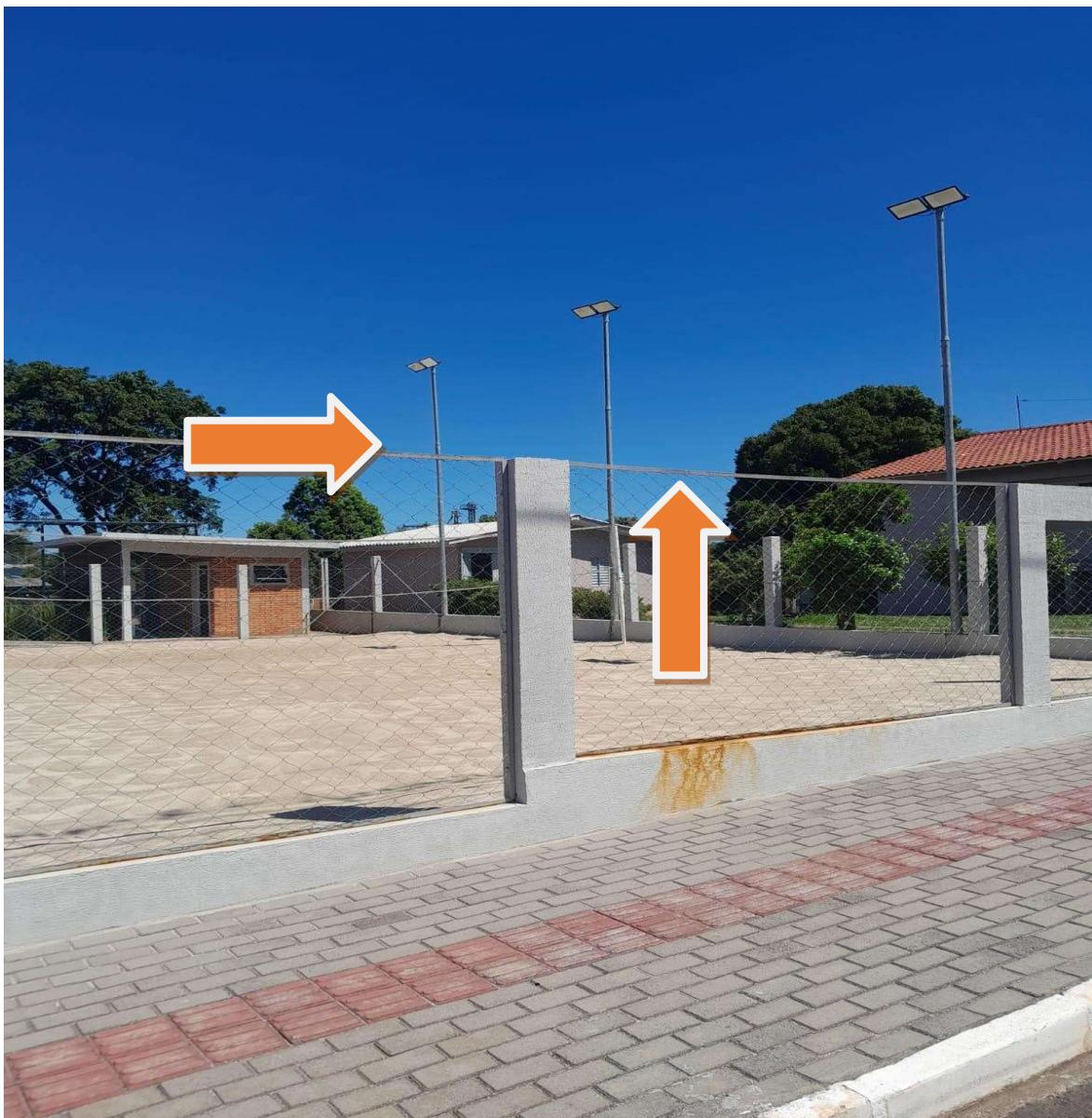
Colocar cerca galvanizada com altura de 3 metros em todo o perímetro da quadra de areia dimensão conforme memorial descritivo.
