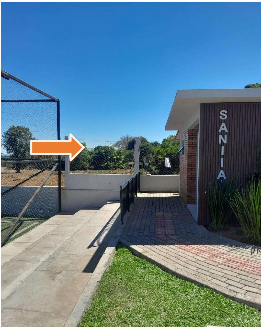
Refazer pilar de concreto e instalar tela galvanizada conforme altura da quadra de areia.
